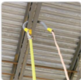
4. Потяните свободный конец каната, при помощи наконечника вниз. Закрепите свободный конец каната, на структуре, при помощи текстильной петли с карабином
