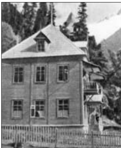
Дом Центральной спасательной службы в Домбае
