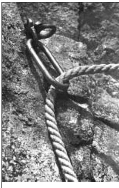
Альпинистская веревка из манильской пеньки, применявшаяся многие десятилетия до появления веревок из синтетических материалов (фото 1934)
