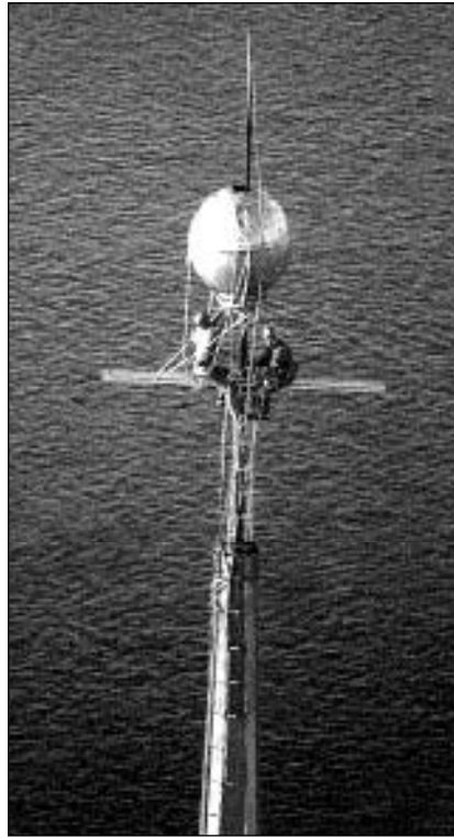
Подготовка «яблока» шпиля Петропавловской крепости (СПб) к демонтажу и спуску для ремонта
