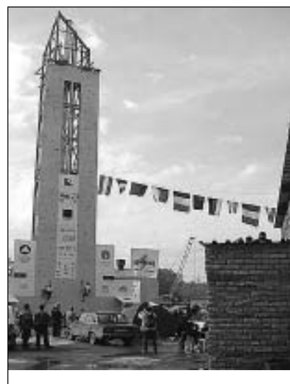
25-метровая стена в Екатеринбурге
